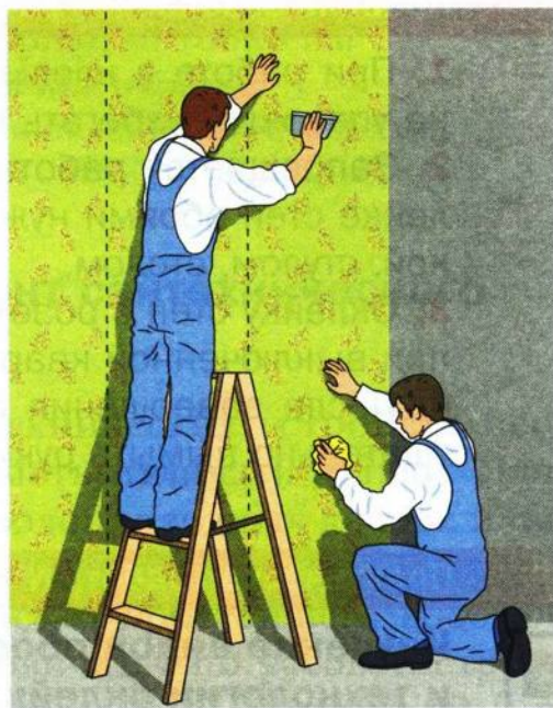
Рис. 85. Оклейка стен обоями
